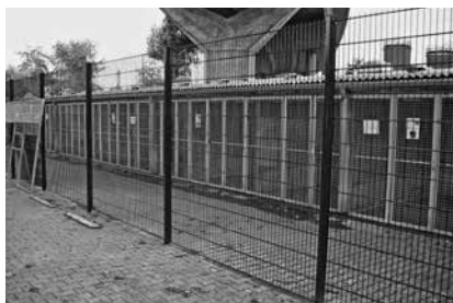
Auslauf mit Sichtschutz
